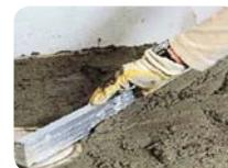
**3** Нанесете следващото количество приготвен разтвор максимално бързо, преди първият слой да започне да стяга. След полагане на материала загладете с маламашка или подходяща машина (тип хеликоптер). За допълнително втвърдяване на повърхностите в помещения, изложени на износване може да се използват повърхностни втвърдители.
