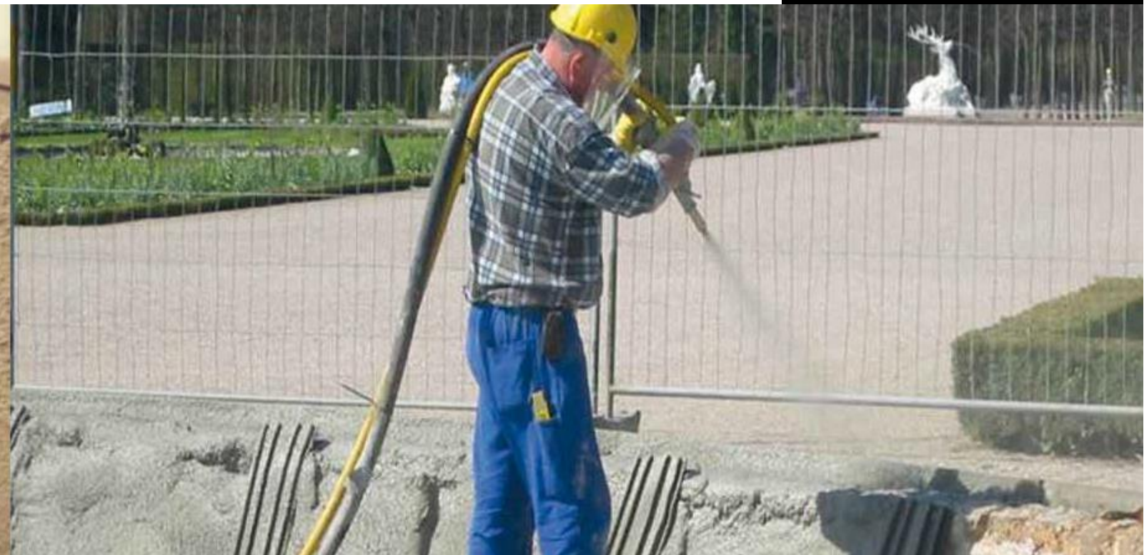
SAKRET SPCC – системи за заместване на бетон 1-комп. съгласно RL-SIB, ZTV-ING за мокро пръскане
