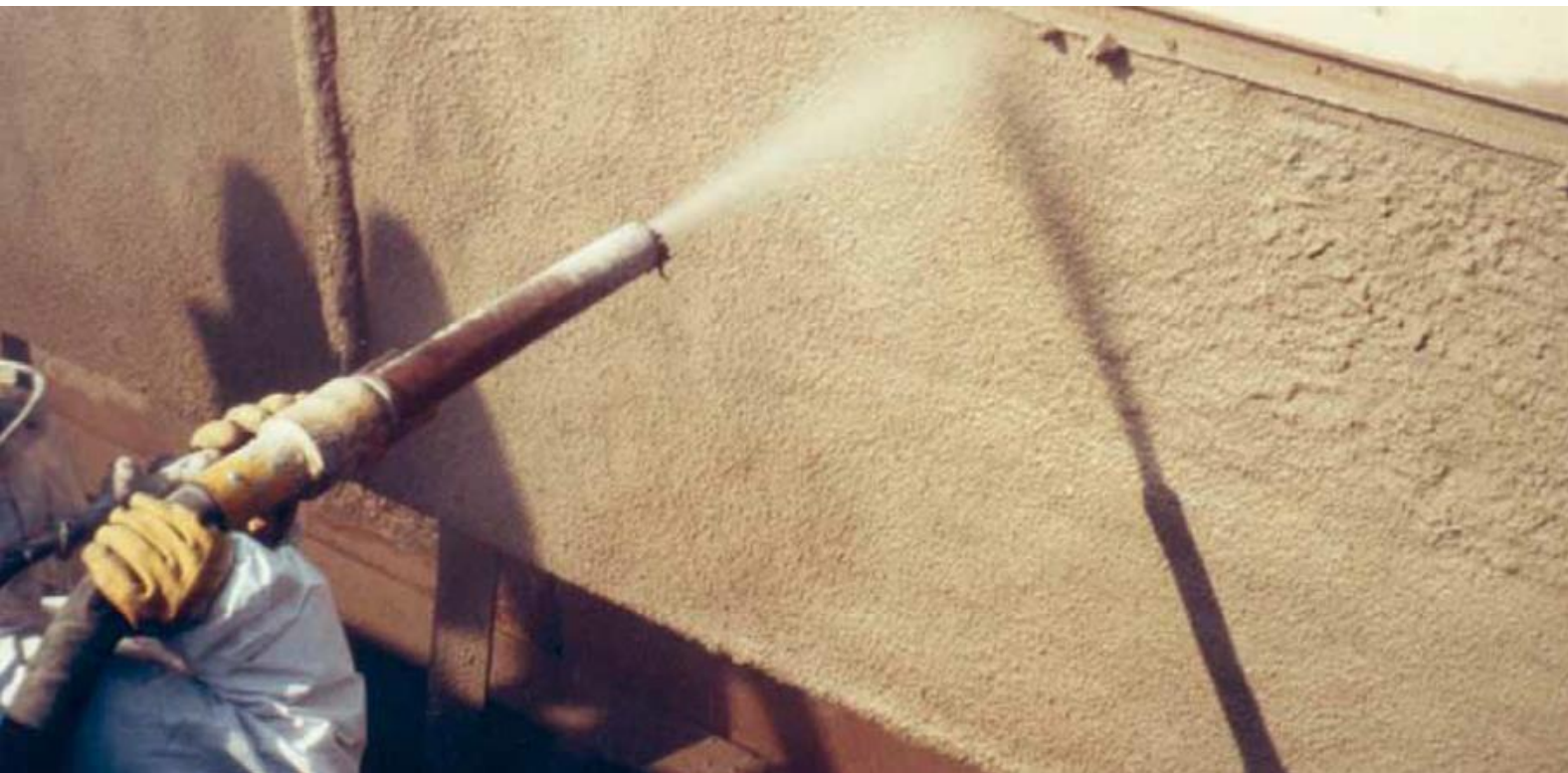
SAKRET SPCC – система за заместване на бетон 1-комп. съгласно RL-SIB, ZTV-ING за сухо пръскане
