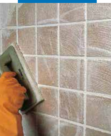
Финиширане на стена с единично изпечени плочки с подложка Scotch-Brite®
