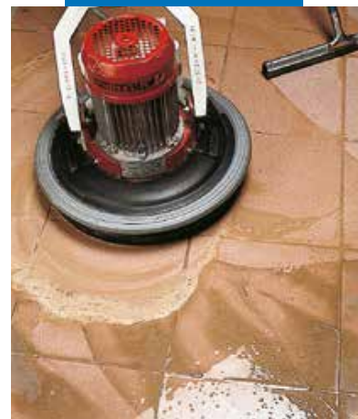
Финиширане на под с гранитогресни плочки с електрическа пердашка с единична четка или с гумена скребка
