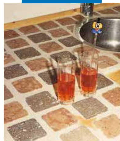
Пример за лепен и фугиран кухненски работен плот
