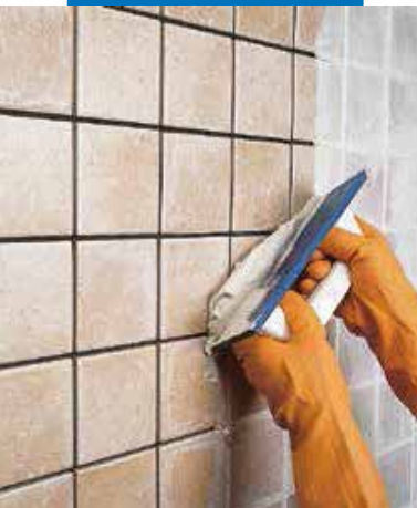
Фугиране на стена с единично изпечени плочки с помощта на пердашка
