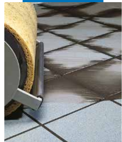
Финишна обработка на под с машина
