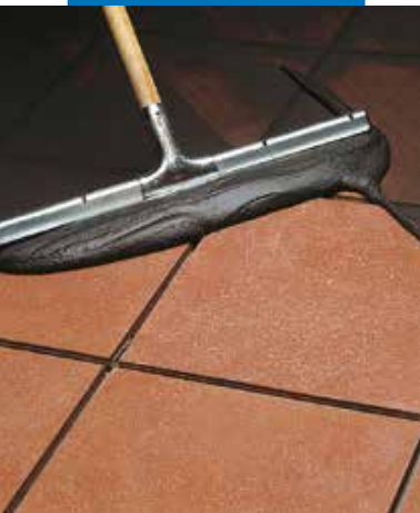
Фугиране на подови, теракотни плочи с гумена шпакла с дълга дръжка
