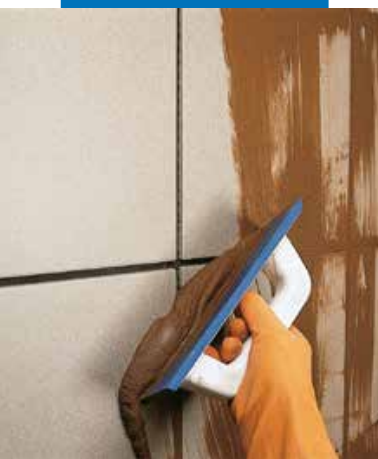
Фугиране на плочки по външната страна на пердашка
