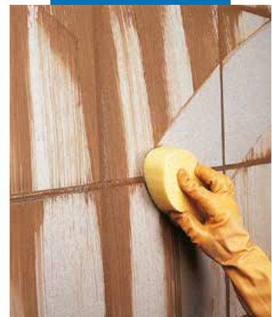
Финишна обработка на стена с гъба
