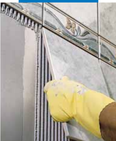
Полагане на еднократно печени плочки върху стенна замазка
