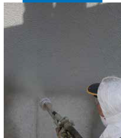
Пример за полагане на Mapelast върху виадукт чрез впръскване
