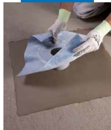
Drain Vertikal върху Mapelastic
