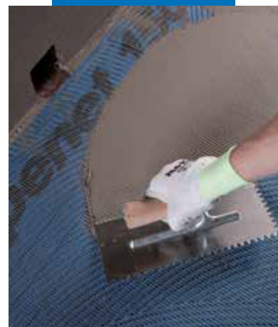
Полагане на Mapelastic върху Mapenet 150
