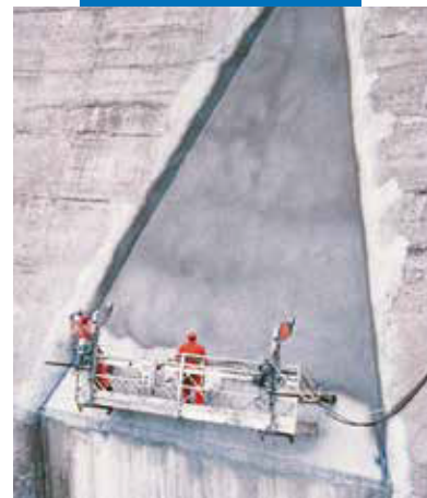
Пример за Mapelast , положен върху язовир чрез впръскване
