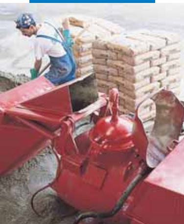
Смесване на Торсет с автоматична помпа
