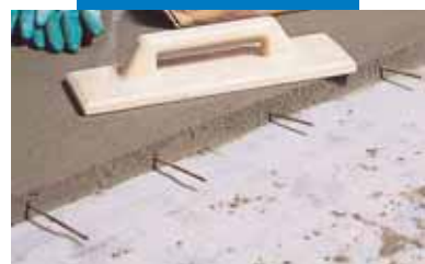
Детайл от замазка с Торсет с арматурни желяза
