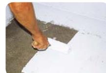
**4** Към полагане на следващи покрития, трябва да се премине най-малко след 1 - 3 часа (**weber.prim 801** трябва да бъде сух). Това време е при температура +20° С и се удължава при ниски температури и се скъсява при високи температури или при добра вентилация.
