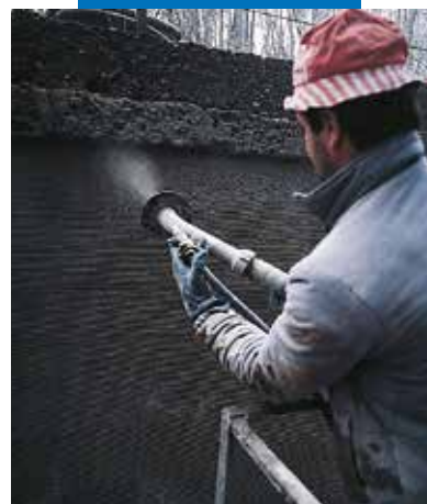
Хидроелектрически канал "Бертини" - Робиате (Комо) - Италия: полагане чрез впръскване
