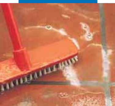
Почистване с Keranet течност с четка за полиране
