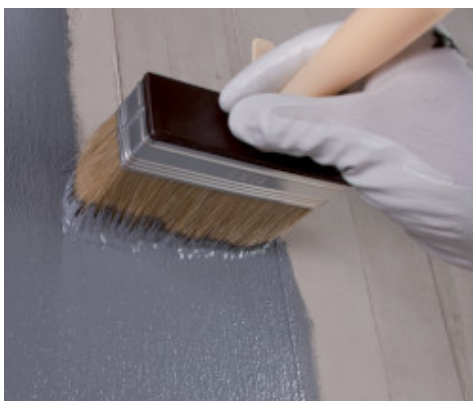
Нанасяне на Eco Prim Grip Plus върху бетон с четка
