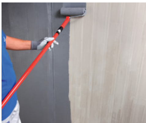
Нанасяне на Eco Prim Grip Plus върху бетон с валик
