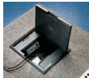
Sportello con scatola a scomparsa per prese elettriche e telefoniche. Floor outlet with housing for electrical, telephone and data sockets.
